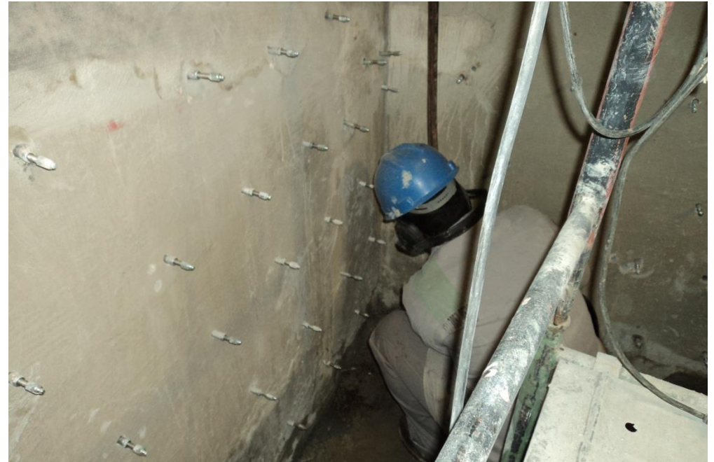
Injeção de gel acrílico
