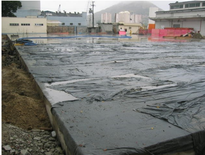
Cura com manta da cisterna com 3 milhões de m 3 de água .
