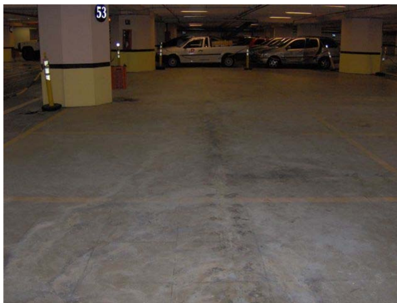
Figura 7 – Vista geral após a conclusão
