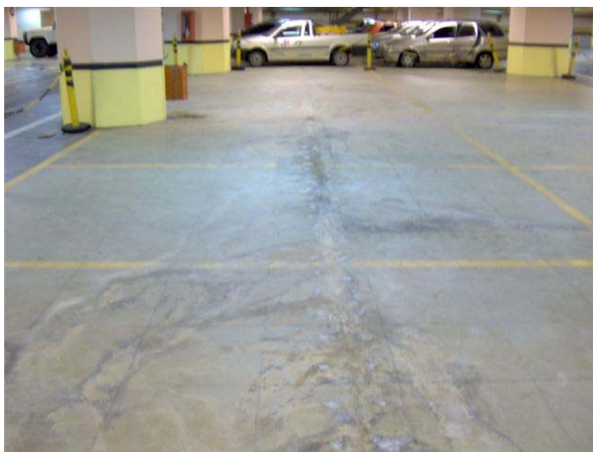
Figura 8 – Vista geral após a conclusão
