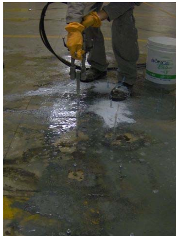
Figura 6 – Engate da pistola no bico de perfuração para injeção de resina
