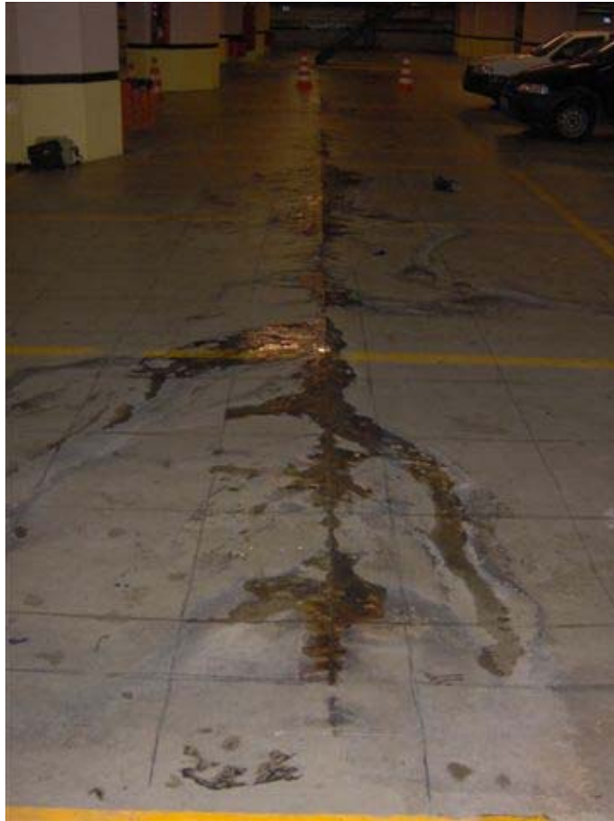
Figura 1 – Detalhe de infiltrações e mapeamento
