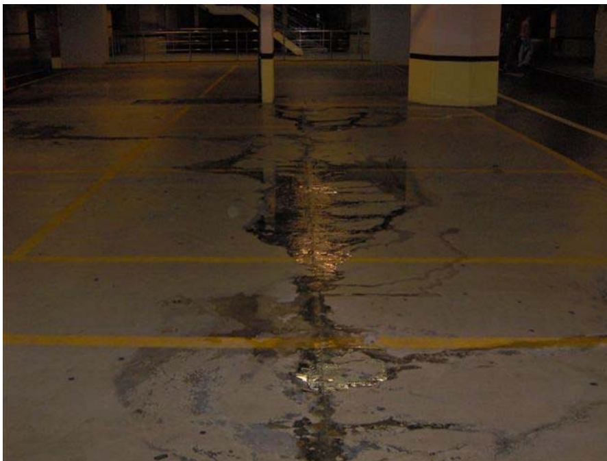
Figura 1 – Detalhe de infiltrações e mapeamento
