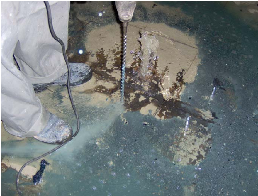
Figura 3 – Execução de furos
